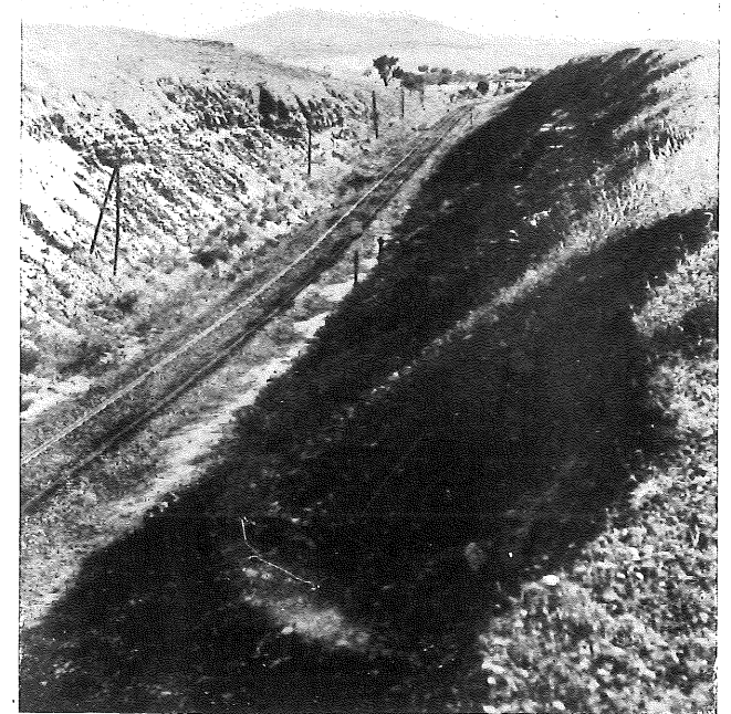
Fig. 2.—Cascajos y aluviones arcillo-areniscos, descansando sobre bancos de arcillas rojas que integran la formación pliocena, cortados por la trinchera del ferrocarril de Mérida a Sevilla, en el Km. 3,500. Al fondo la redondeada silueta del cerro de calizas cambrianas de Carija.
