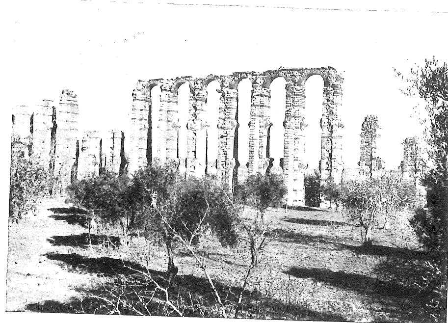
Fig. 1.—El acueducto romano de Mérida. Ruinas denominadas Los Milagros, que conducían el agua del embalse de Proserpina a la población.
